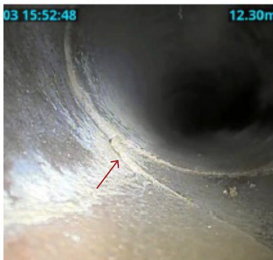
Fissure ouverte d'une canalisation Extrait du rapport d'investigations sur les réseaux - DRIM
