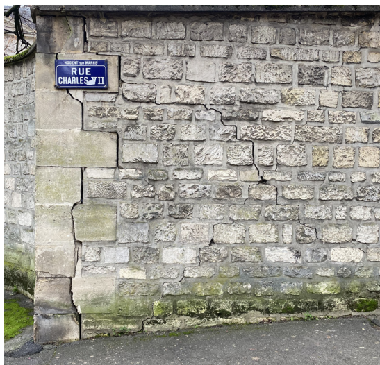
Linéaire nord - Fissuration et désolidarisation d'une partie du mur d'enceinte - Portail d'entrée nord Photos Atelier Ergon
