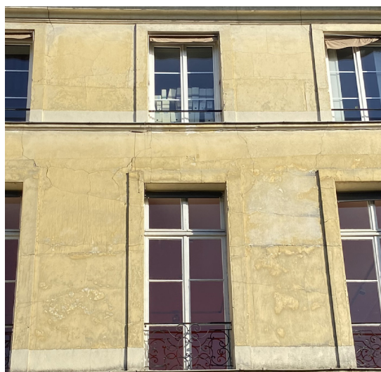
Exemple de craquellement de l'enduit en façade H12 Photo Atelier Ergon
