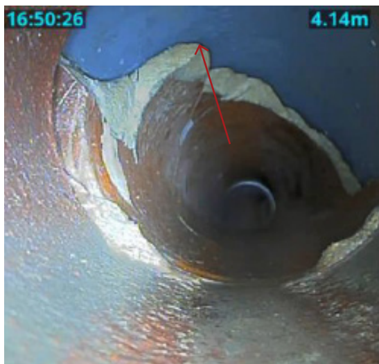
Effondrement partiel d'une canalisation d'eaux usées Extrait du rapport d'investigations sur les réseaux - DRIM
