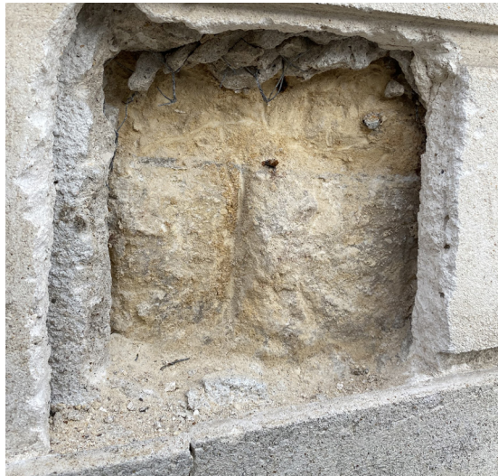
Maçonnerie de gros moellons Photo Atelier Ergon
