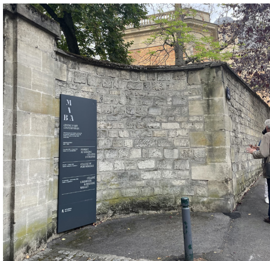
Demi-lune et chaîne d'angle en pierre de taille Photo Atelier Ergon
