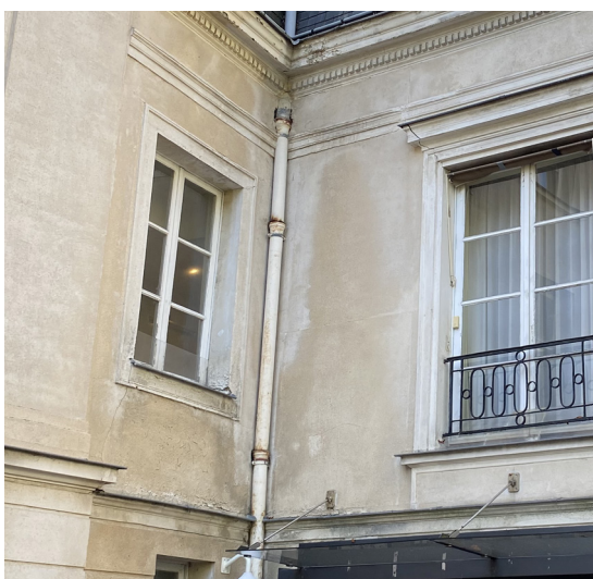
Traces d'humidité et lessivage, angle H10-H11 Photo Atelier Ergon
