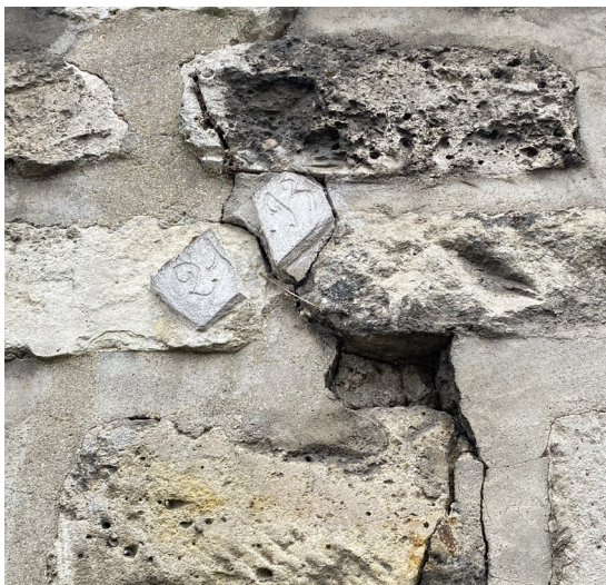
Linéaire nord - fissuration du mur - présence de témoins en plâtre Photos Atelier Ergon
