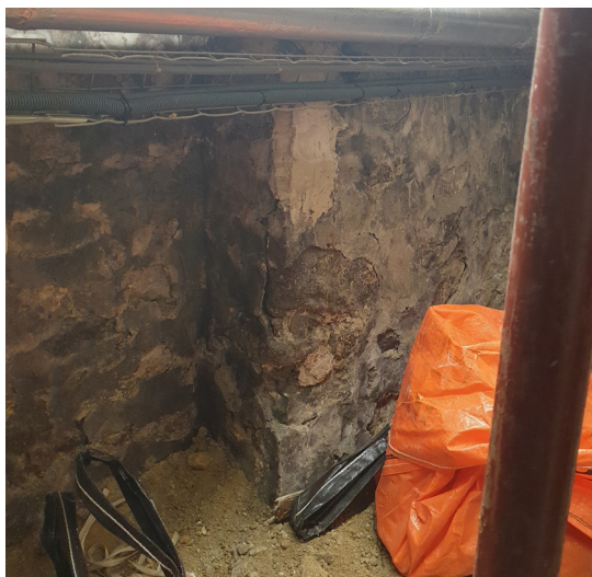
Présence d'humidité et désorganisation des maçonneries du sous-sol de la MABA Photo Atelier Ergon
