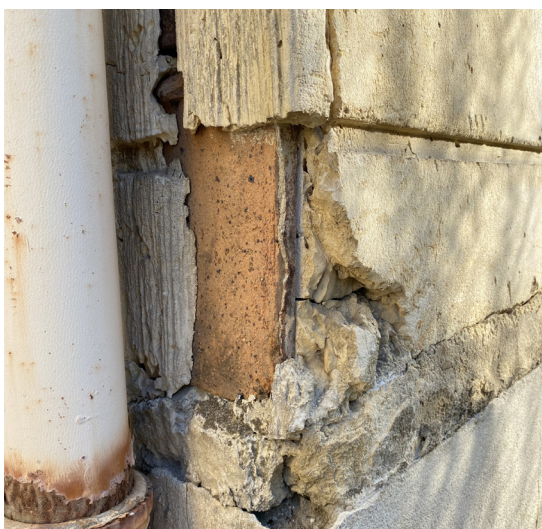
Fissure et décollement d'enduit de la MABA Photo Atelier Ergon
