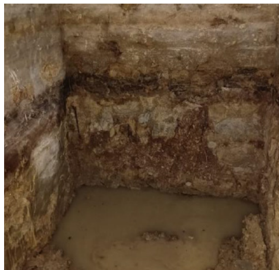
Emprise partielle de la galerie voûtée sous le niveau du sous-sol et présence d'eau Coupe Géomètre - Annotations Atelier Ergon - Photo DRIM
