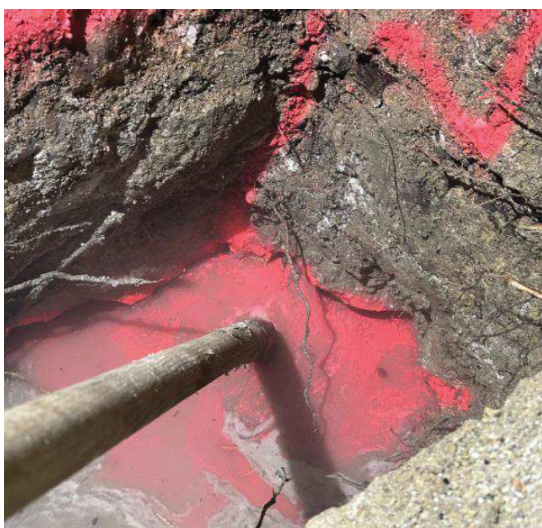
Présence d'eau dans la fouille F8bis Extrait rapport ECR
