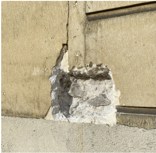
Double épaisseur d'enduit - MABA, avant-corps (H13) Photo Atelier Ergon
