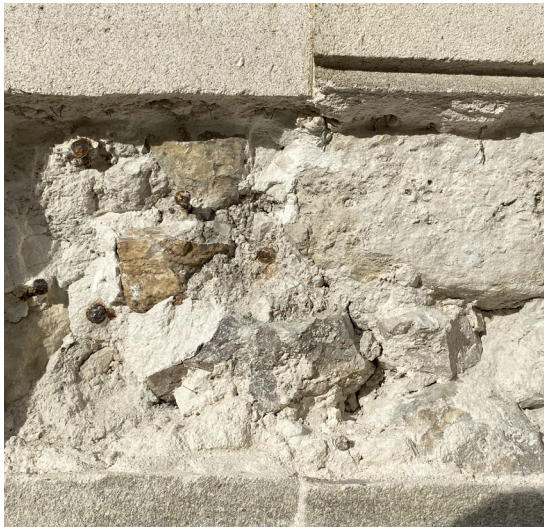
Maçonnerie de gros moellon Photo Atelier Ergon
