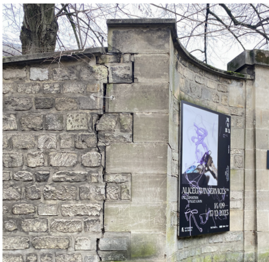
Linéaire nord - Fissuration et désolidarisation d'une partie du mur d'enceinte - Portail d'entrée nord Photos Atelier Ergon
