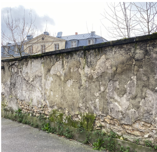
Linéaire Nord - desquamation et lessivage de la maçonnerie Photos Atelier Ergon
