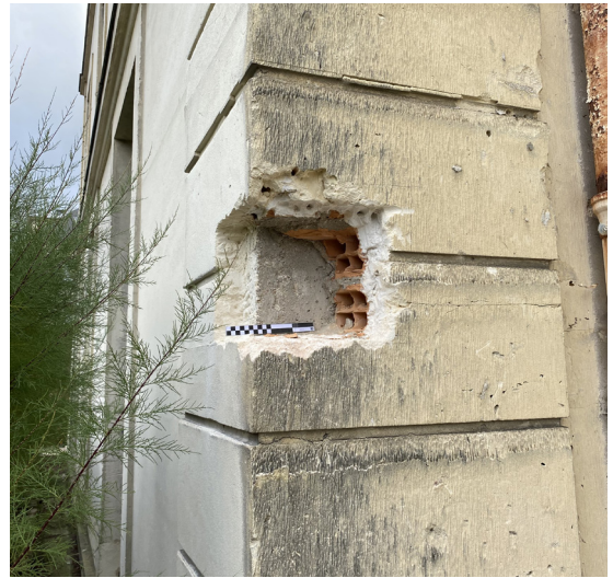
Simple épaisseur d'enduit et doublage brique façade est de la MABA (H12) Photo Atelier Ergon
