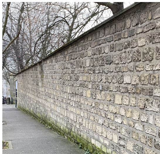
Linéaire nord - Maçonnerie de moellons Photo Atelier Ergon
