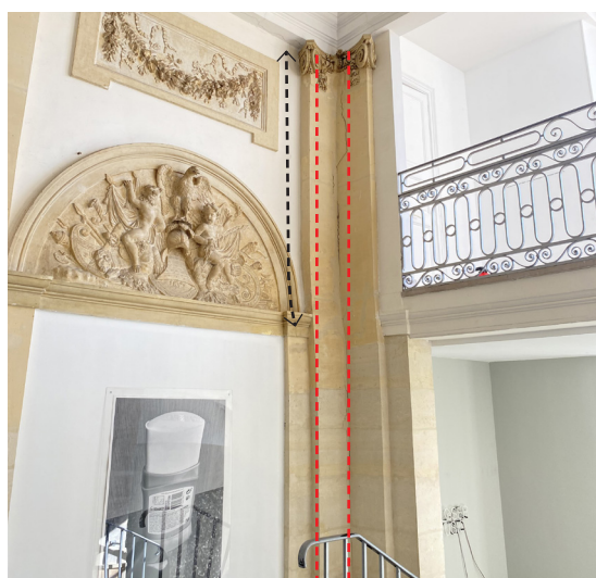
Déformation importante d'un mur de refend de la MABA Photo Atelier Ergon
