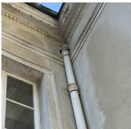
Canalisation entraînant une forte présence d'humidité à l'angle des façades H10 et H11 Photo Atelier Ergon
