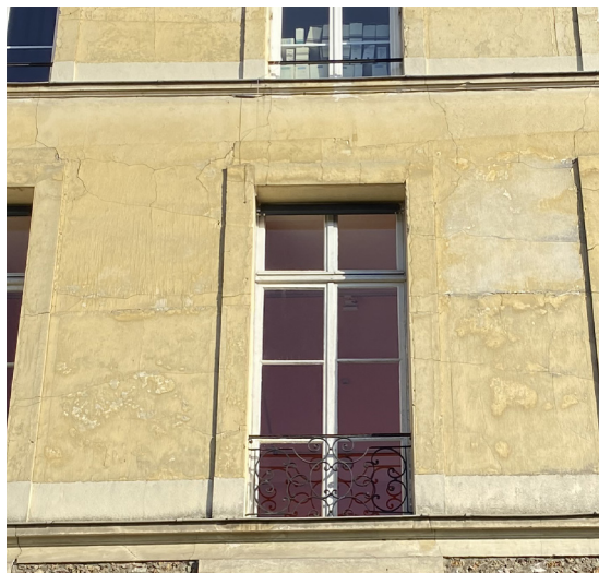
Traces d'humidité témoignant d'un lessivage au niveau des zones d'enduit craquelé de la MABA Photo Atelier Ergon
